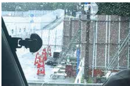
●国立競技場の工事現場入り口 (当日はあいにくの雨模様)
